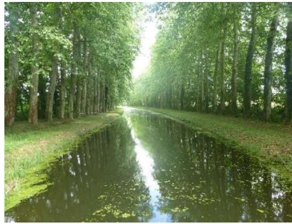
Alignement d'arbres le long du Canal de Berry déclassé
